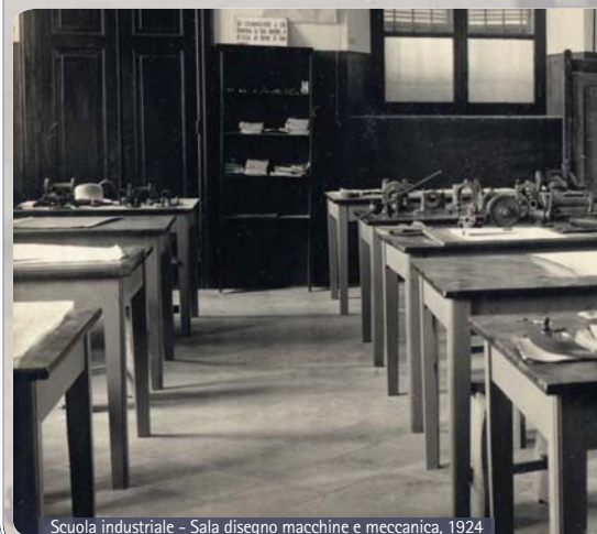
Scuola industriale - Sala disegno macchine e meccanica, 1924
